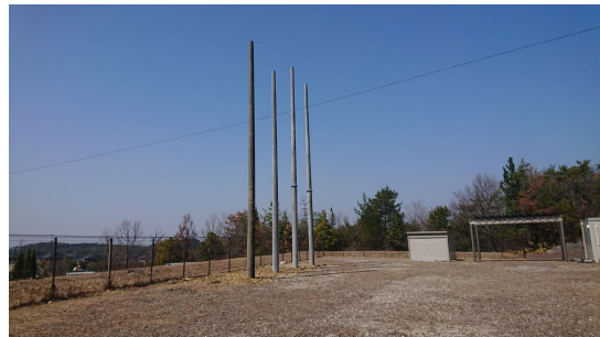
写真5 北校地に建柱した電柱
