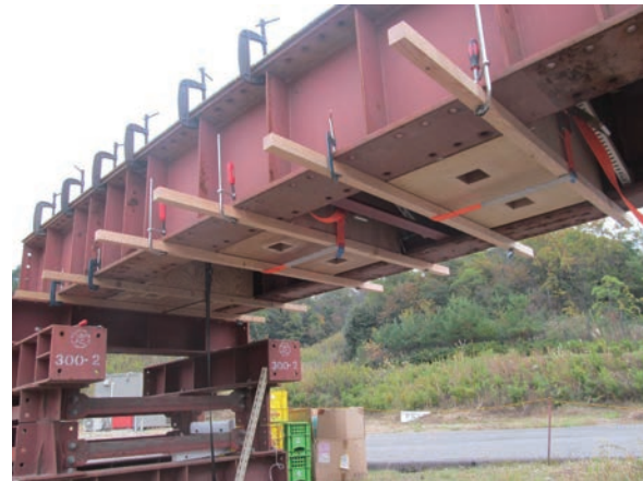
橋梁 1/5 模型実験
