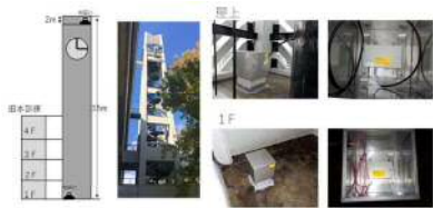
図 2 地震計設置概要図および設置写真
